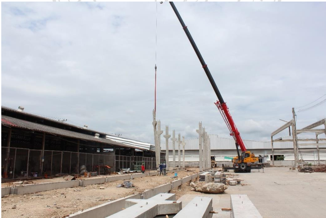
(d) Precast construction for factory building
