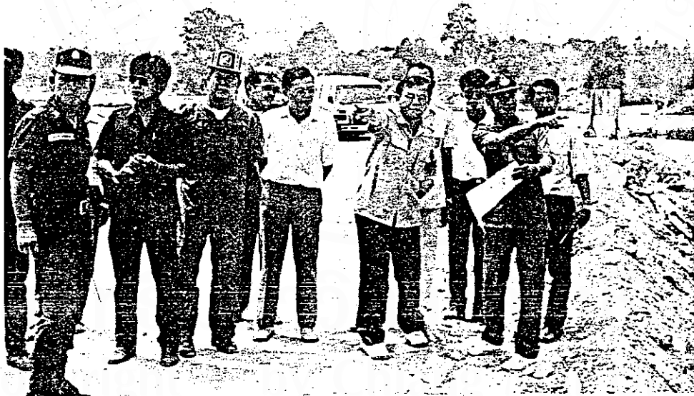
ดูงานปากมูล นายชาติสง่า โมฬีชาติ รองผู้ว่าราชการจังหวัดอุบลราชธานี ในฐานะ ประธานอนุกรรมการชุมชนสัมพันธ์ โครงการโรงไฟฟ้าพลังน้ำเขื่อนปากมูล ตรวจเยี่ยม คูผลการดำเนินงานก่อสร้างโครงการฯ เขื่อนปากมูล อำเภอโขงเจียม จังหวัดอุบลราช ธานี โดยมี นายประสิทธิ์ ศรีสายเชื้อ หัวหน้าโครงการโรงไฟฟ้าพลังน้ำเขื่อนปากมูล พร้อมคณะให้การต้อนรับและนำชมบริเวณงานก่อสร้าง ■
