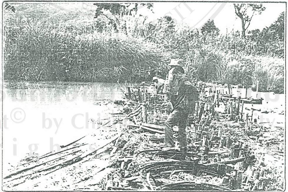
ภาพที่ 9 แก่ท่อน้ำที่ชาวบ้านได้ตรวจสอบความแข็งแรงของฝายก่อนถูกลำน้ำ
