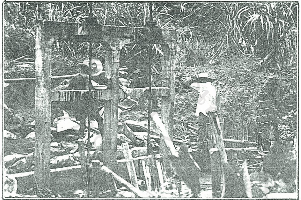
ภาพที่ 8 ประตุน้ำที่ชาวบ้านนำมาใช้แบบคอนกรีตและกวางเหล็ก เพื่อประสิทธิภาพการควบคุมน้ำเข้าสู่คลองสายใหญ่
