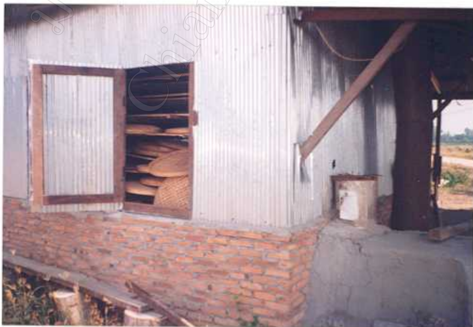
ภาพที่ 5 เตาบ่มใบยาสูบดัดแปลงเป็นเตาอบลำไย
