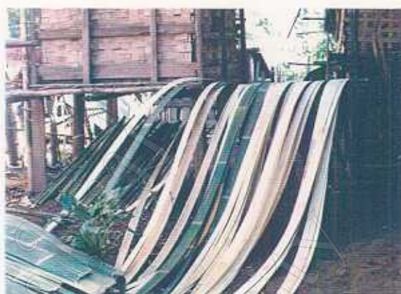
รูป 18 ฟากไม้ไผ่เตรียมไว้สำหรับสร้างบ้าน
