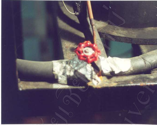
รูปที่ 3.11 วาล์วควบคุมอัตราการไหล
