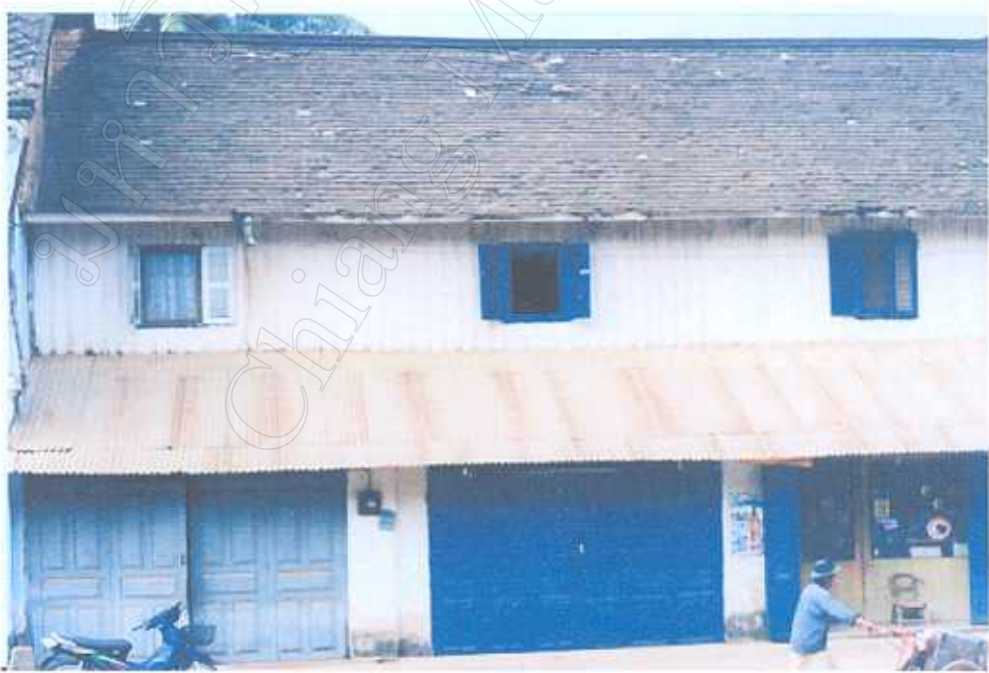
รูป 15 อาคารหลังหนึ่งที่หลังคาชั้นบนมุงด้วยดินขอแต่ชั้นล่างต่อเติมด้วยสังกะสี
