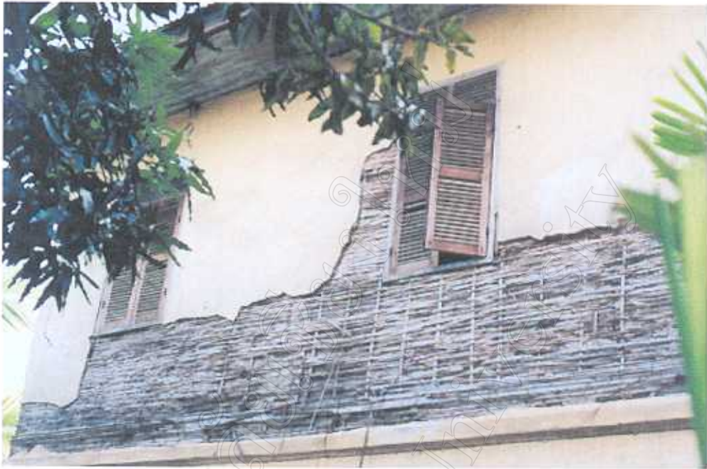
รูป 2 อาคารในสภาพทรุดโทรมเผยให้เห็นวัสดุภายใน (ตอกซี)
