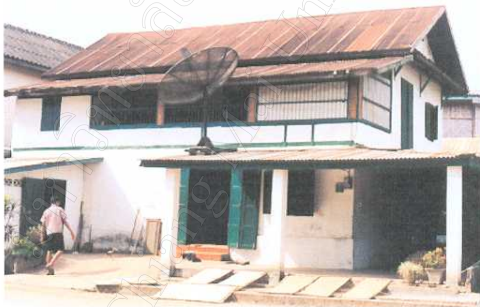
รูป 20 จานรับสัญญาณดาวเทียมที่ติดตั้งอยู่บนกันสาดของบ้าน
