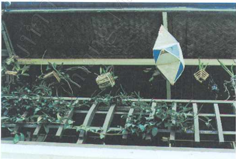
รูป 3 ภายในตัวอาคารจะเห็นเพดานที่ทำมาจากไม้ไผ่สาน
