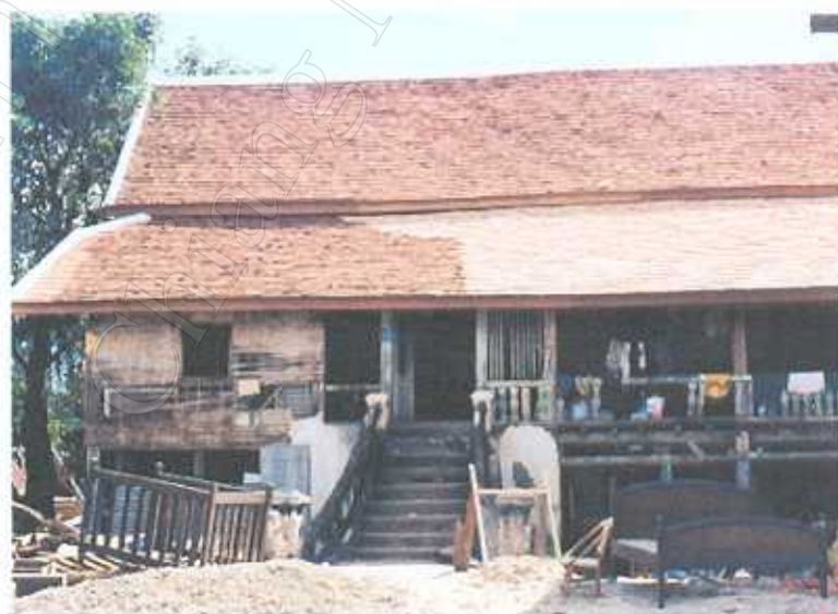
รูป 25 อาคารตรงข้ามวัดแสนที่กำลังปรับปรุงซ่อมแซม
