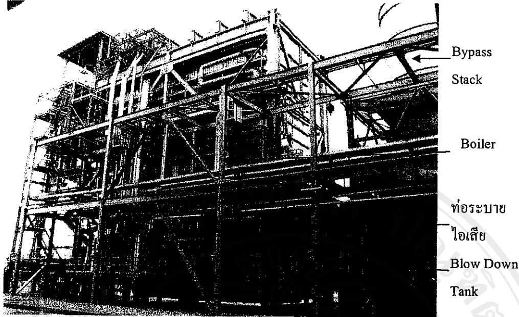
รูปที่ 3.13 แสดงหม้อต้มไอน้ำที่ติดตั้งเชื่อมต่อกับท่อระบายไอเสียของระบบกังหันก๊าซ
