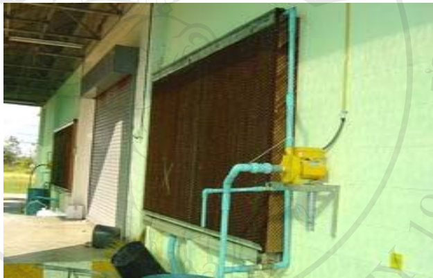
ภาพที่ 4.15 มอเตอร์ปั๊มน้ำที่ใช้กับระบบระบายอากาศในห้องคัดลูกไก่
