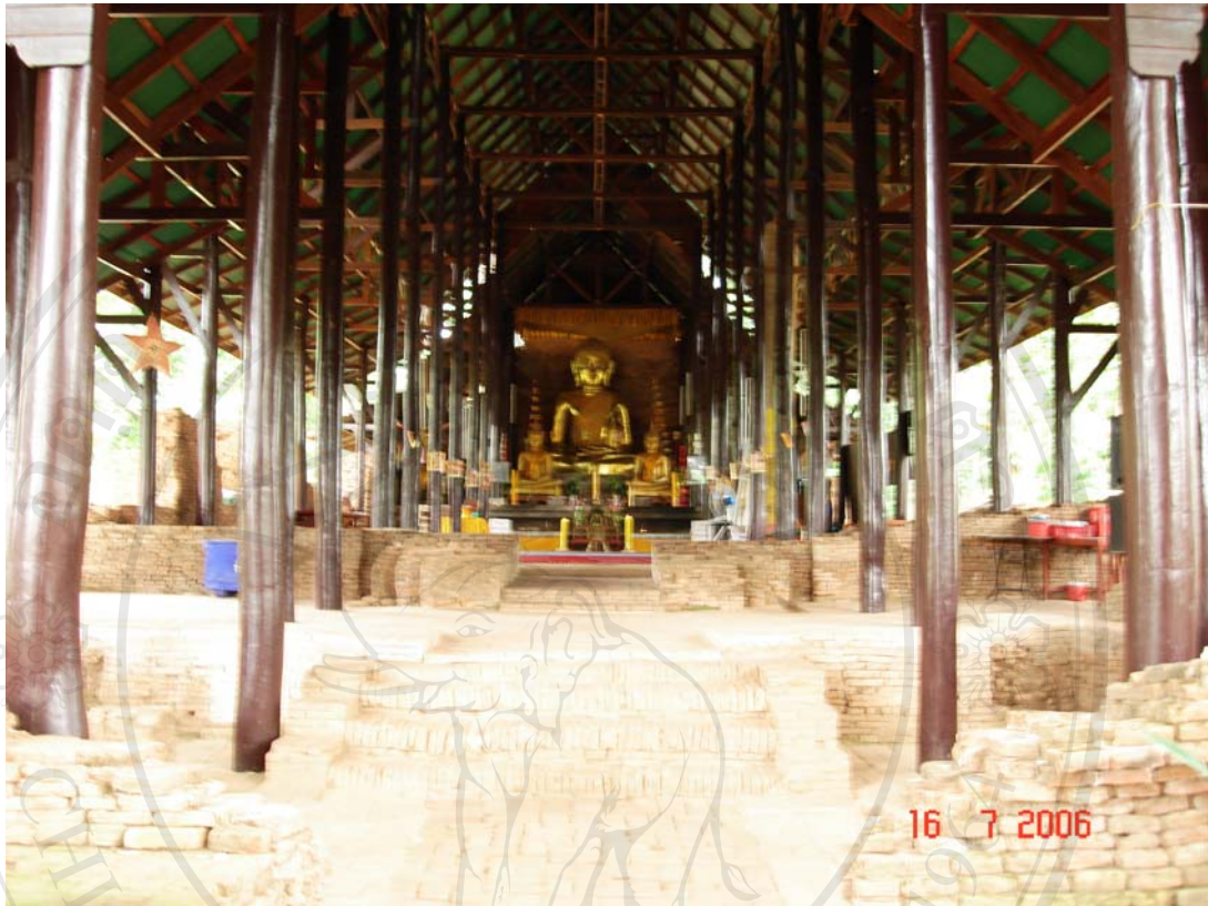
รูปที่ 4 ภายในวัดเจดีย์หลวงที่เริ่มมีการบูรณะบางส่วน
