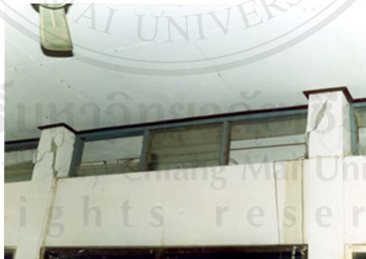
รูป 16 ความเสียหายเนื่องจากการเกิดแผ่นดินไหวที่ อ.พาน จ.เชียงราย ปี พ.ศ. 2537
