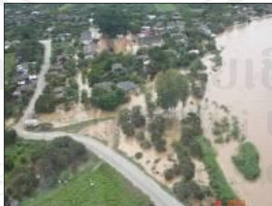
รูปที่ 2.1 รูปแบบทั่วไปของระบบป้องกันน้ำไหลเข้าท่วมพื้นที่แบบถาวร ลักษณะคันกั้นน้ำ
