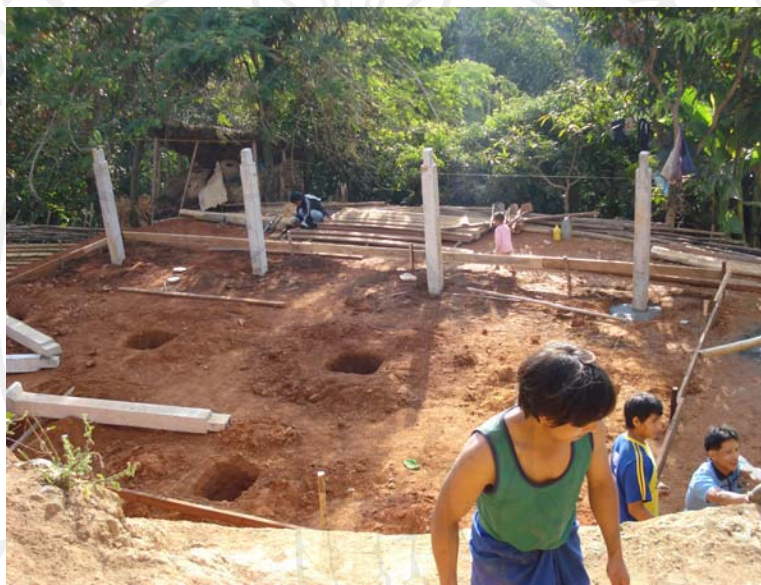
ภาพที่ 5.1 การขุดพื้นลงเสาปูนเพื่อสร้างบ้านของ “นาสี”
