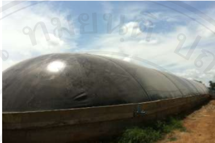
รูปที่ 2.3 ระบบก๊าซชีวภาพแบบ CMU-CD
