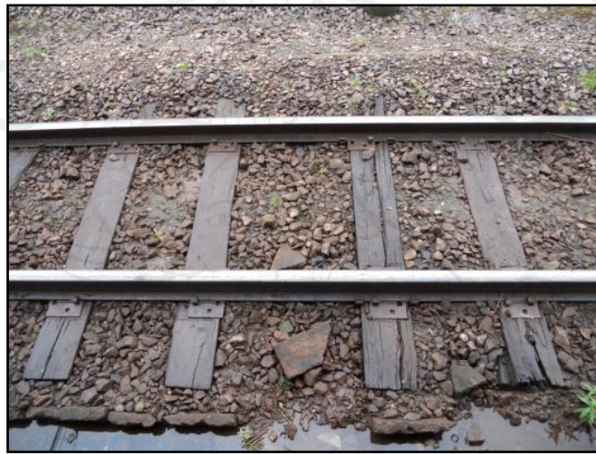
รูป 1 รางที่ยังใช้ไม่หมดนอนอยู่ (รางสับหลัก และรางอื่นๆ ที่ไม่ใช่รางหลักในบริเวณสถานีรถไฟ
