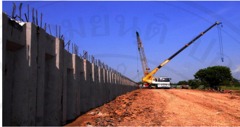
รูป 6 เขื่อนป้องกันน้ำท่วมรอบสวนอุตสาหกรรมโรจนะ
