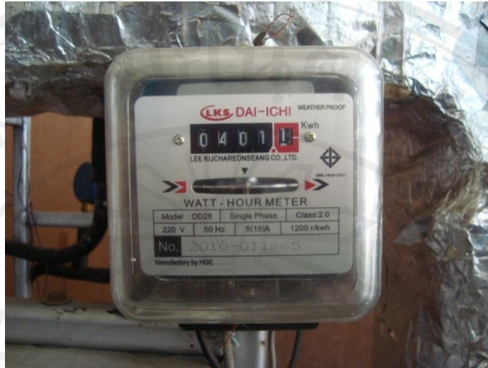
รูป ข.6 เครื่องวัดพลังงานไฟฟ้า กิโลวัตต์-เอว-มิเตอร์
