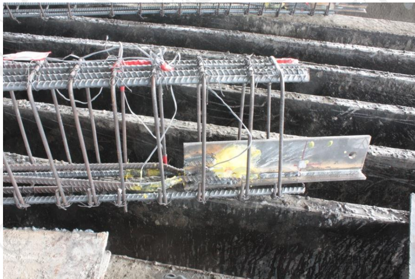
รูปที่ 3.14 การเตรียมเหล็กเสริมของชั้นส่วนคาน
