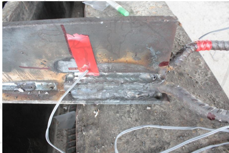
รูปที่ 4.69 การติด strain gauge ที่แกนสะเทินของเหล็กหน้าตัดตัว T
