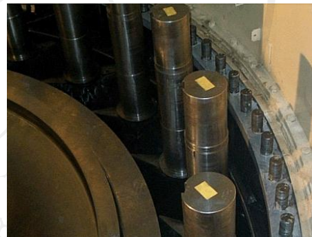
รูปที่ 2.15 ช่องนำน้ำเข้า (Guide Vane)
