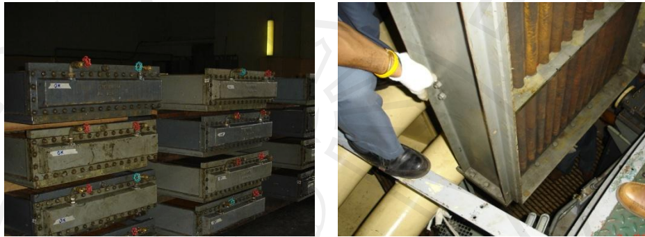
รูปที่ 2.19 อุปกรณ์ระบายความร้อน (Generator Air Cooler)
