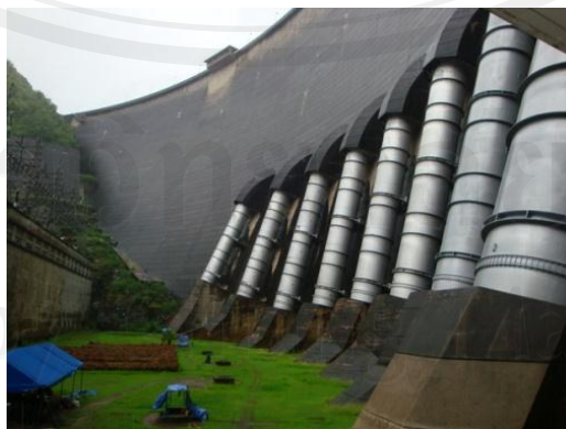
รูปที่ 2.12 ท่อส่งน้ำ (Penstock)
