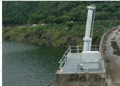
รูปที่ 2.11 ประตูรับน้ำ (Intake Gate)
