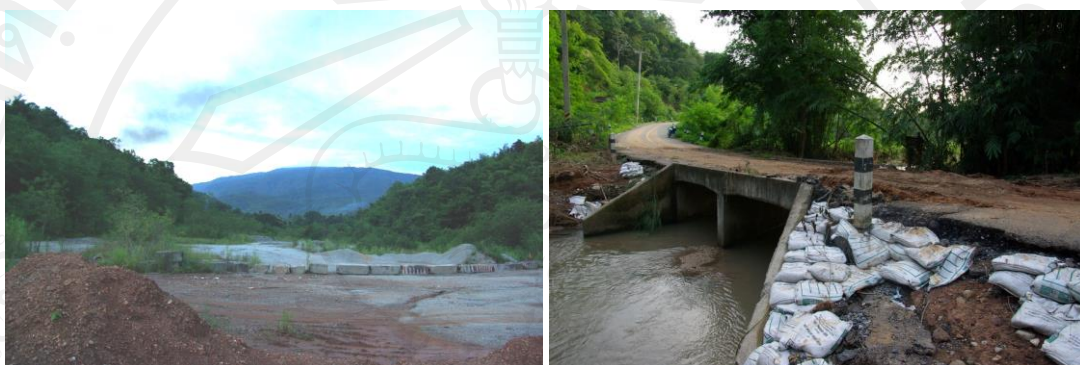
ภาพ 4.3 เหมืองหินเก่าบริเวณบ้านทุ่งโป่ง ตำบลบ้านปง อำเภอหางดง จังหวัดเชียงใหม่ (ซ้าย) และสะพานข้ามลำห้วยแม่เหิยะบริเวณสบปิงในชุมชนแม่เหิยะใน (ขวา)
