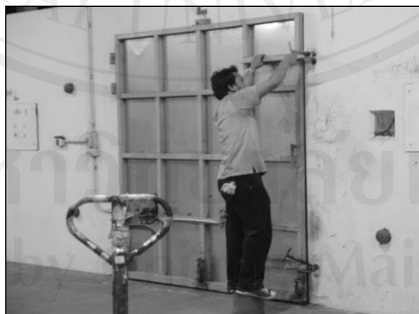
ภาพ 12 การปิดประตูห้องรม และการตรวจเช็คเพื่อป้องกันการรั่วของก๊าซซัลเฟอร์ไดออกไซด์
