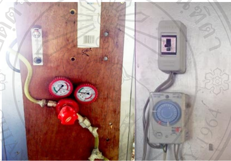
รูป 3.8 แผงควบคุมอัตราการไหลของก๊าซและอุปกรณ์ควบคุมระบบไฟ
