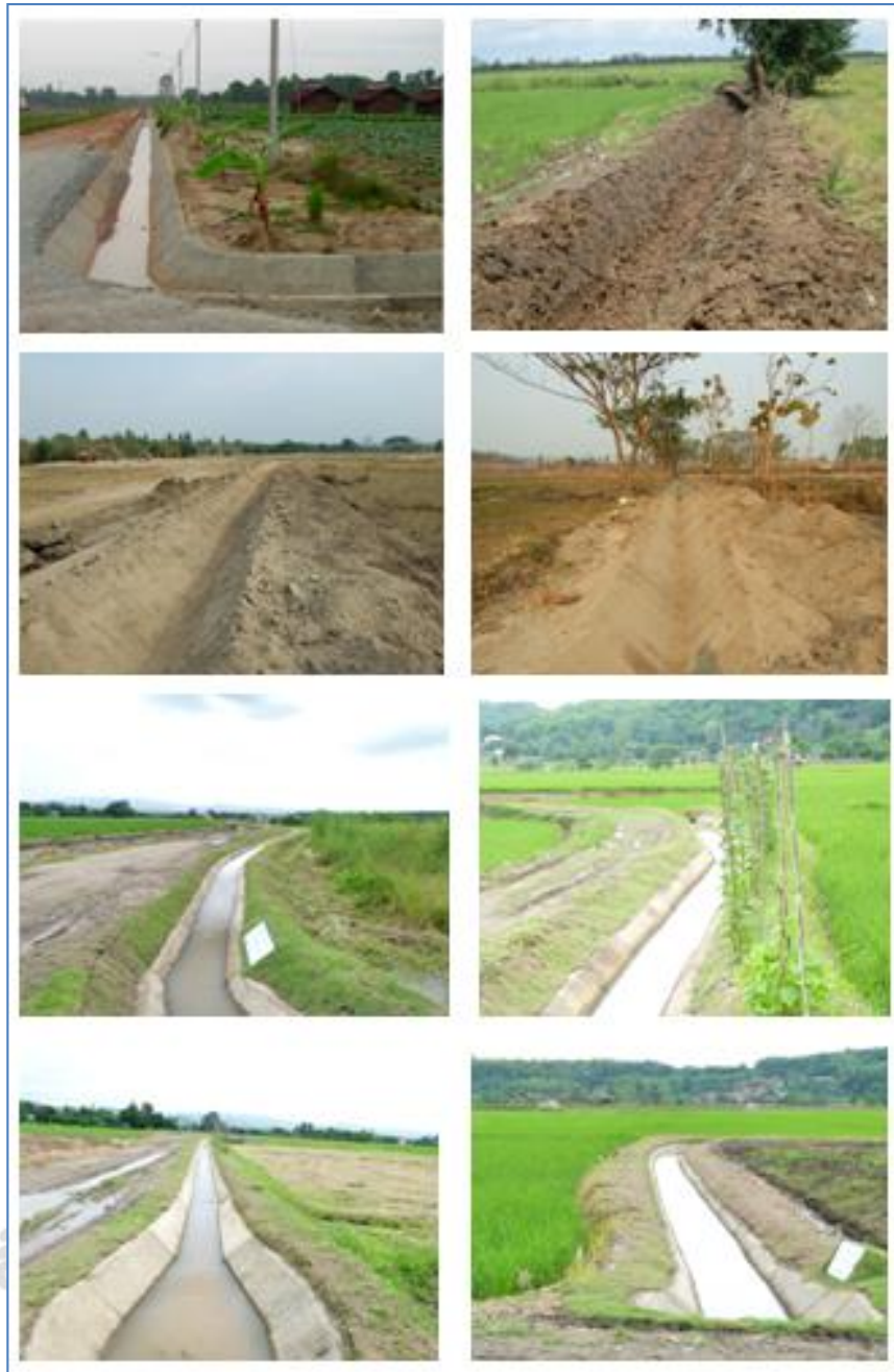
ภาพที่ 4.3 ภาพแสดงภารกิจงาน โครงการจัดระบบน้ำเพื่อเกษตรกรรม
