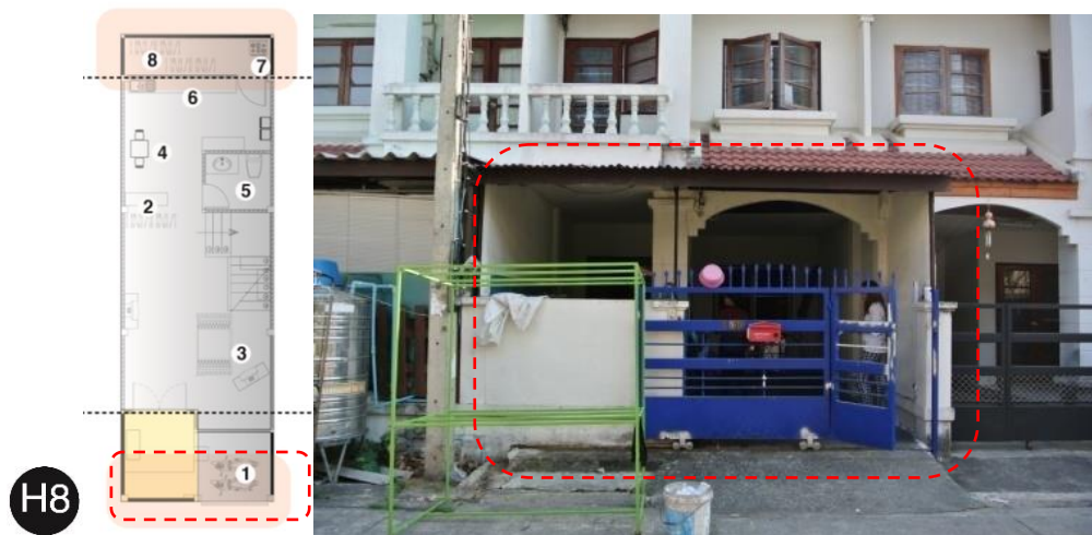
ภาพที่ 4.19 ภาพการต่อเติมอาคารเพื่อใช้พื้นที่เพื่อการประกอบกิจการเกี่ยวกับอาหาร กลุ่มคนที่มีหน้าร้านภายนอกบ้านพักอาศัย ได้แก่บ้าน H8
