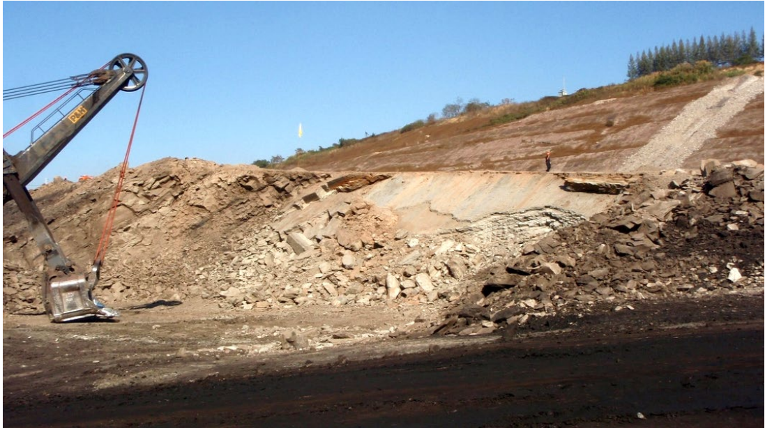
รูปที่ 2.7 กรณีหน้างานขุดชนพื้นที่ SE East-wall พังทลายใน Mode 1 (กองวิศวกรรมธรณี เหมือนแม่เมาะ, 2557)
