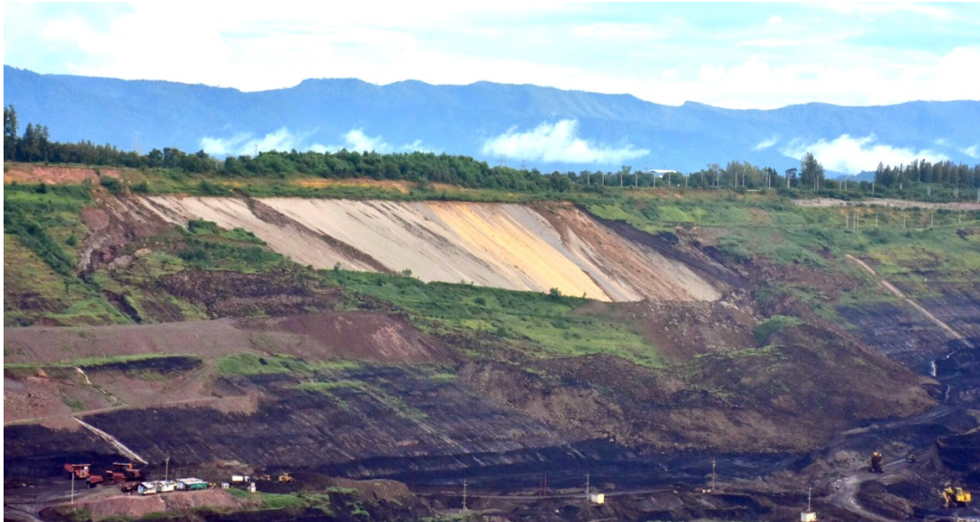
รูปที่ 2.11 กรณีผนังบ่อเหมืองพื้นที่ SE East-wall พังทลายใน Mode 3 (กองวิศวกรรมธรณี เหมืองแม่เมาะ, 2559)
