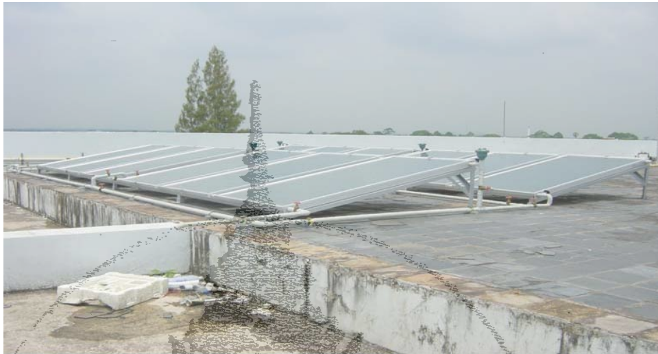
ภาพที่ 2 แสดงการติดตั้งแผงรับรังสีดวงอาทิตย์แบบแผ่นเรียบชนิดมีแผ่นปิดใส ที่ท่า: กรมพัฒนาพลังงานทดแทนและอนุรักษ์พลังงาน, 2550
