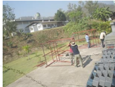
ภาพที่ ก2 การสร้างฐาน แผง Solar collector
