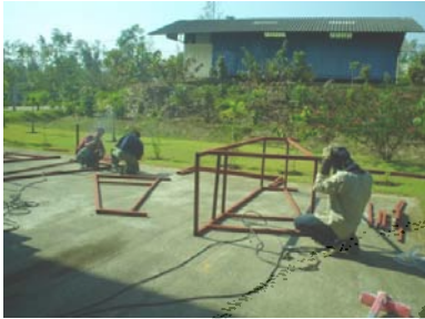
ภาพที่ ก1 การสร้างฐาน แผง Solar collector
