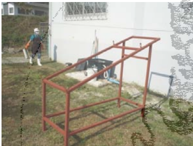
ภาพที่ ก3 การติดตั้งฐาน แผง Solar collector
