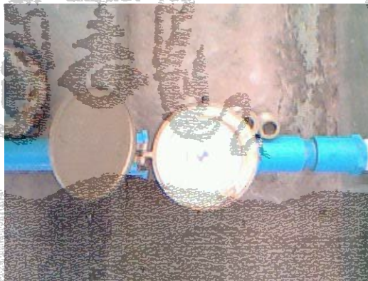
ภาพที่ ก13 มาตรวัดปริมาณการไหลของน้ำ โดยหน่วยวัดปริมาตรน้ำหน่วยเป็นลูกบาศก์เมตร
