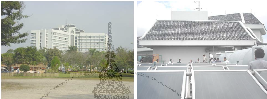
ภาพที่ 5 แสดงระบบผลิตน้ำร้อนแบบผสมผสาน ณ โรงแรมดุสิตไฮสโตนอร์ธ จ.เชียงราย ที่มา: กรมพัฒนาพลังงานทดแทนและอนุรักษ์พลังงาน, 2550
