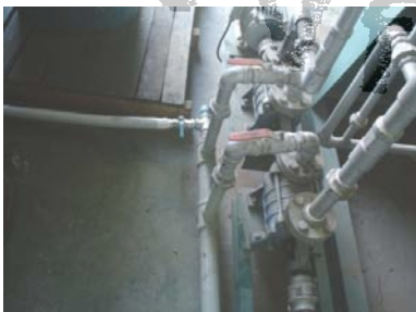
ภาพที่ ก7 การติดตั้งปั๊มและระบบป้อนน้ำ
