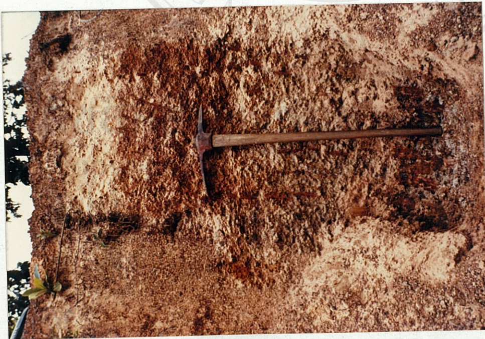
ภาพที่ 5.3 ลักษณะชั้นดินลูกรังในสภาพแวดล้อมที่เป็นดินทราย (ก. จีที 185854 : บ้านทุ่งยางปายแดง อ. ดอยสะเก็ด จ. เชียงใหม่: พ. จีที 073914 : บ้านนิคมหนองเต่า อ. สันทราย จ. เชียงใหม่)
