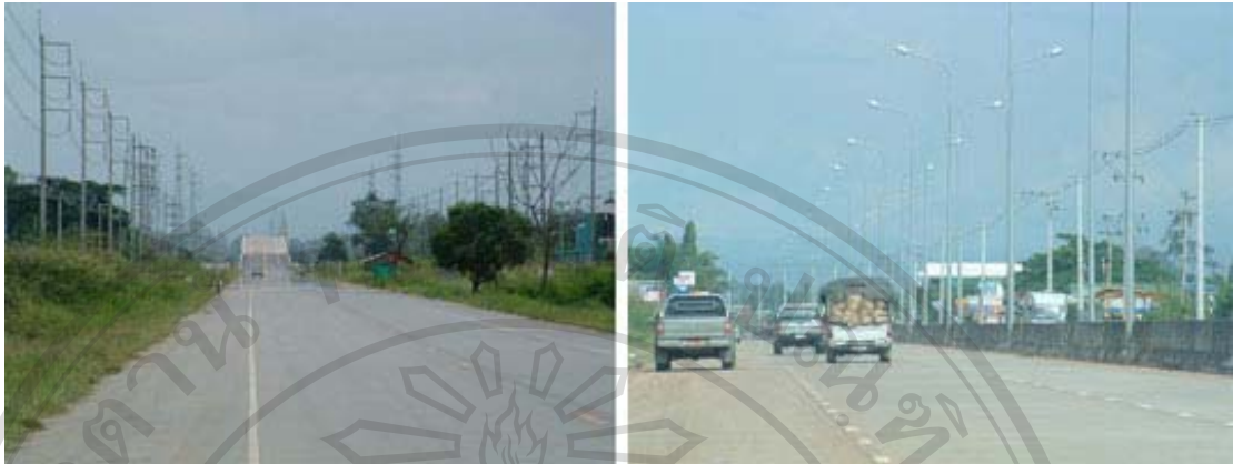
รูป 3.3 ถนนวงแหวนรอบกลางและวงแหวนรอบนอก ภาพซ้ายถนนวงแหวนรอบนอก สร้างเพียง 2 ช่องจราจร ภาพขวาถนนวงแหวนรอบกลาง สร้างแบบเต็มรูปแบบ 6 ช่องจราจร
