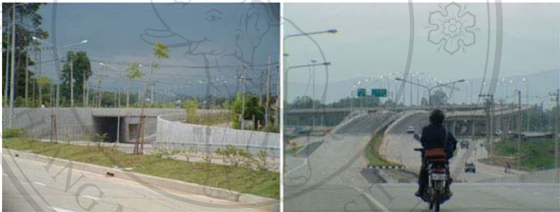
รูป 3.4 จุดตัดระหว่างถนนวงแหวนรอบกลางและถนนรัศมี ภาพซ้ายจุดตัดระหว่างถนนวงแหวนรอบกลางและถนนรัศมีเชียงใหม่-ลำพูน เป็นทางลอด ภาพขวาจุดตัดระหว่างถนนวงแหวนรอบกลางและถนนรัศมีเชียงใหม่-ลำปาง เป็นทางข้าม
