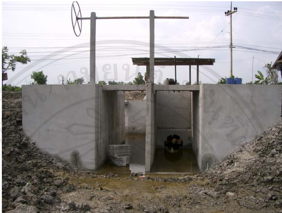
ภาพที่ 9 ภาพถ่ายลักษณะของประตูน้ำคอนกรีต
