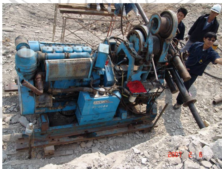
รูป 5.1 เครื่องเจาะหลุมติดตั้งสมอยึดพื้น
