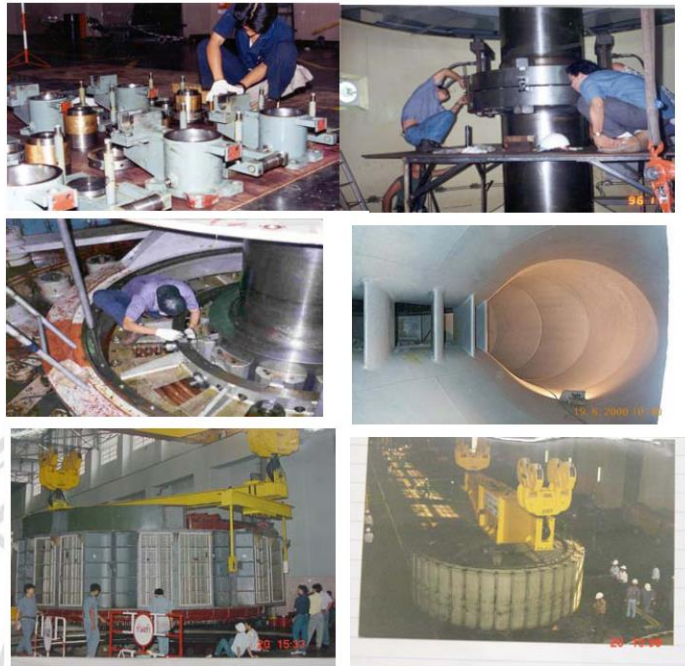
ภาพที่ 2.19 การตรวจซ่อมใหญ่
