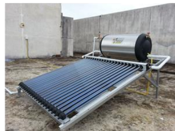
รูปที่ 2.3 เทคโนโลยีผลิตน้ำร้อนด้วยพลังงานแสงอาทิตย์ชนิดไหลเวียนตามธรรมชาติ
