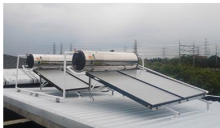
รูปที่ 2.3 เทคโนโลยีผลิตน้ำร้อนด้วยพลังงานแสงอาทิตย์ชนิดไหลเวียนตามธรรมชาติ
