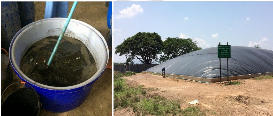
รูปที่ 3.3 เชื้อและลักษณะของบ่อหมักย่อยไร้อากาศจากฟาร์มสุกร
