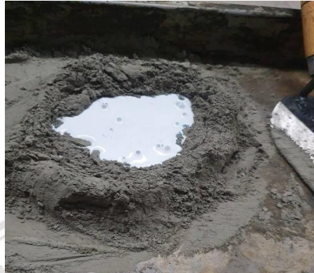
ภาพที่ 3.5 การผสมวัสดุเชื่อมประสานซีเมนต์ - โพลีเมอร์
