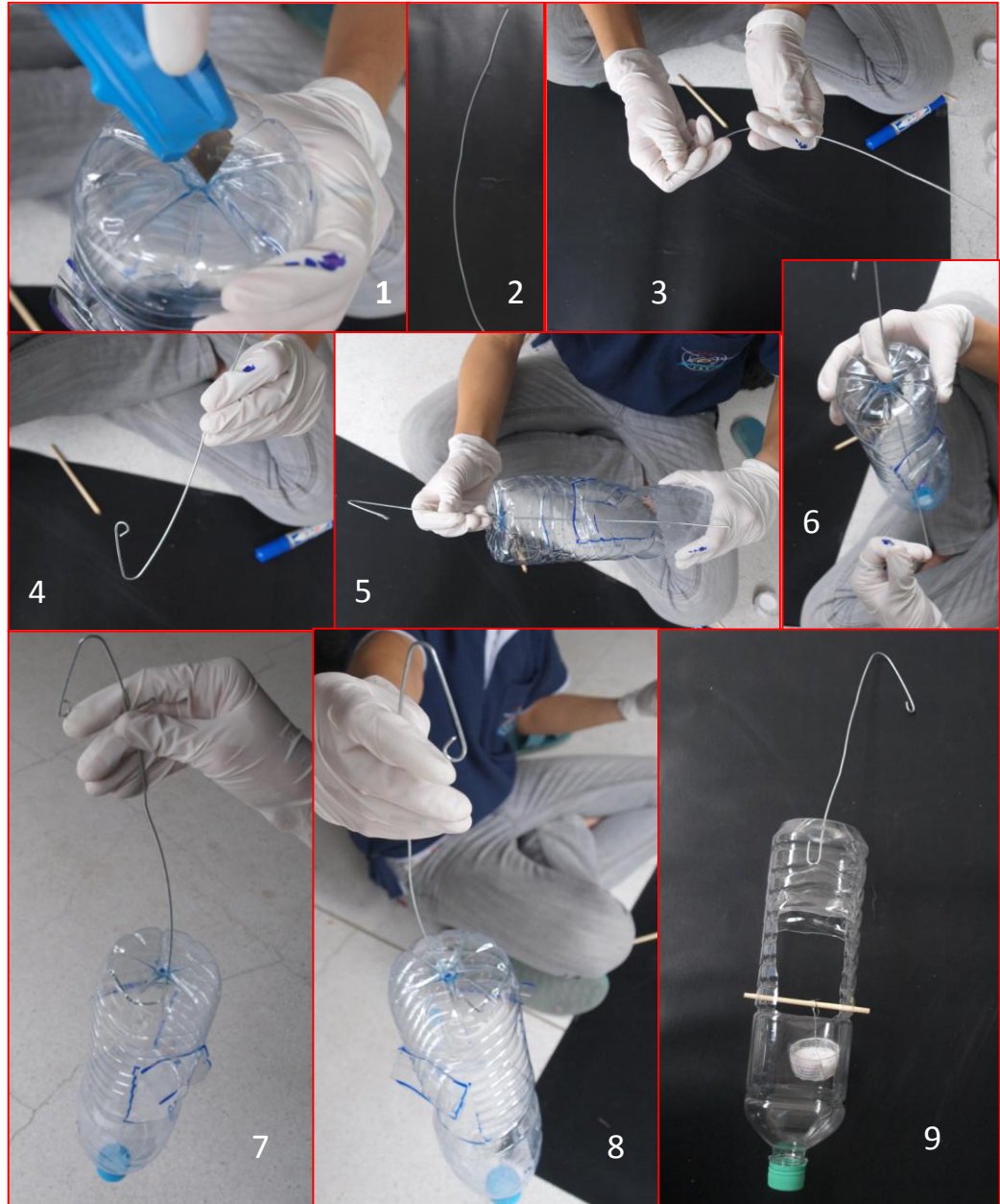
ภาพที่ 3.7 วิธีการเจาะรูขวอน้ำเพื่อทำที่แขวนกับต้นกาแฟ
